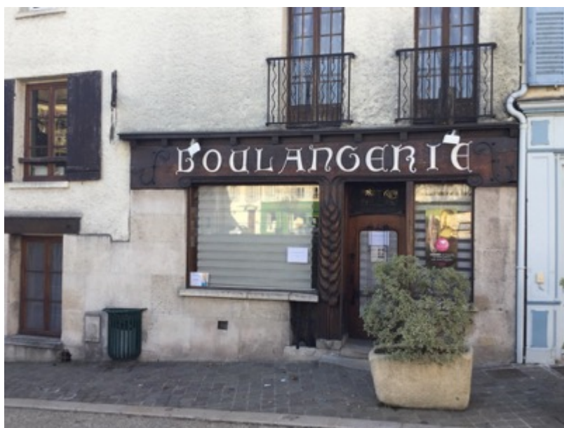
Enseigne lumineuse éclairée par projection (spots), Louveciennes, février 2019
